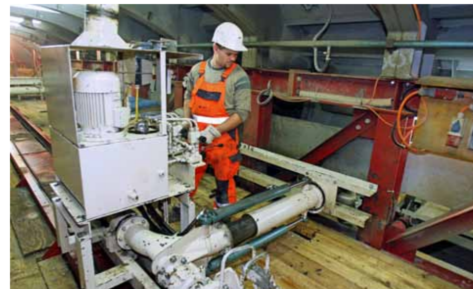
Schalungsarbeiten im neuen Doppelspurtunnel der Koralmbahn zwischen Graz und Klagenfurt.
