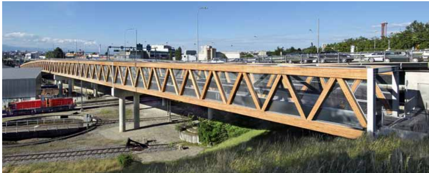
Der Zustand von Holzbrücken könnte zukünftig mit RFID-Sensoren überwacht werden. Hier ein Fussgänger- und Velosteg in Genf.
