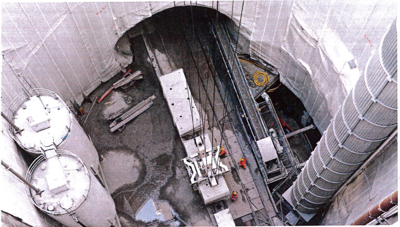
Tübbingverladung durch den Bauschacht
