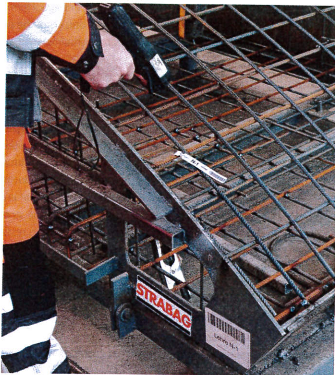
Scan Bewehrungskorb Scan reinforcement cage
