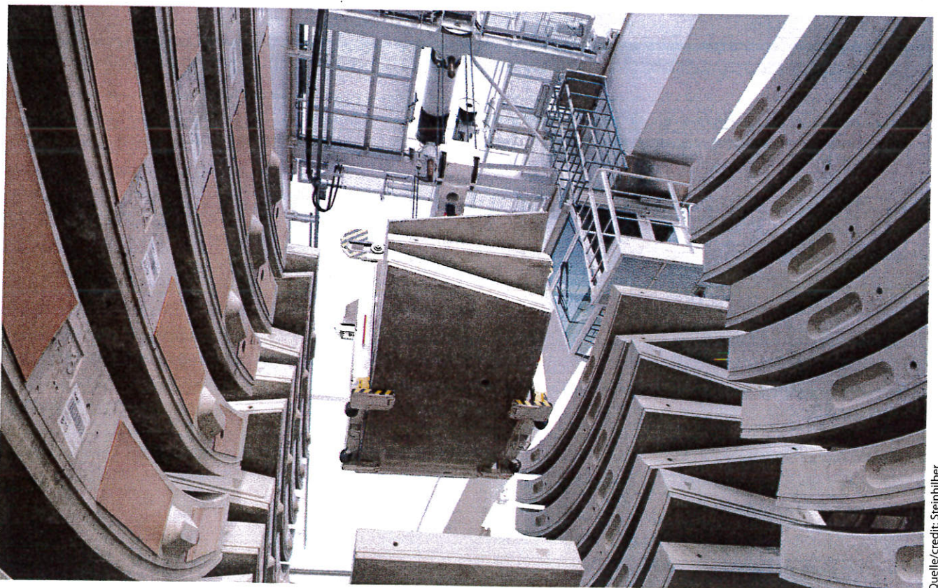
Verladung von Tübbing mit dem Portalkran im Tübbinglager des Koralmtunnel KAT2 Transport of segments with a portal crane in the segment storage of the Koralm Tunnel KAT2
