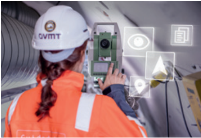
Navigations- und Ergänzungssysteme Large Diameter Tunnelling
